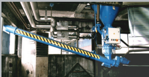
Стационарный вакуумный агрегат, предварительный сепаратор и система вакуумного трубопровода. Взрывозащищенные разгрузочные устройства: двойной сдвигной клапан, шнековый транспортер.
