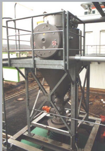
Фильтр-сепаратор во взрывозащищенном исполнении с клапаном сброса избыточного взрывного давления EVN . Клапан EVN оснащен пламегасителем и не разрушается при взрыве.
