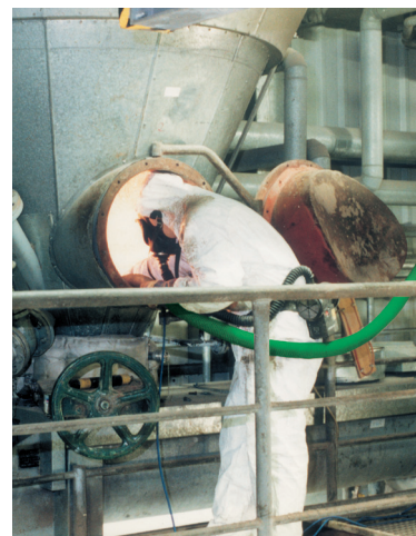
Очистка сборных бункеров
