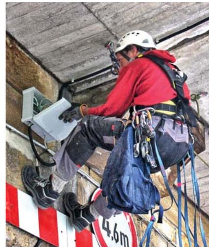
Измерительная станция, установленная под проезжей частью моста, с системой сбора данных ALMEMO® и узлами сети
