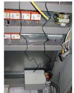
Система сбора данных ALMEMO® MA 5690 1M09 TG3, установленная на DIN-рейку в электрошкафу
